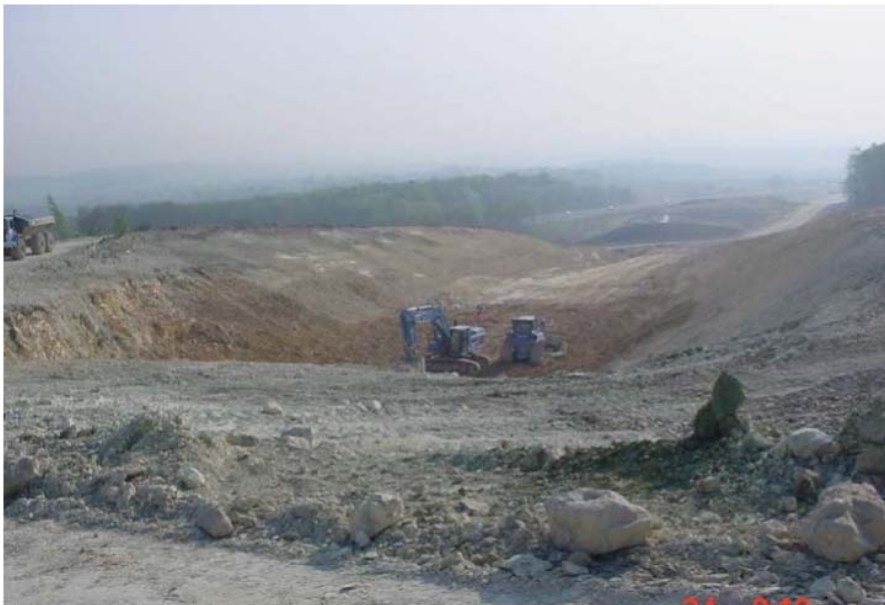
Terrassement de la Tranchée Couverte
